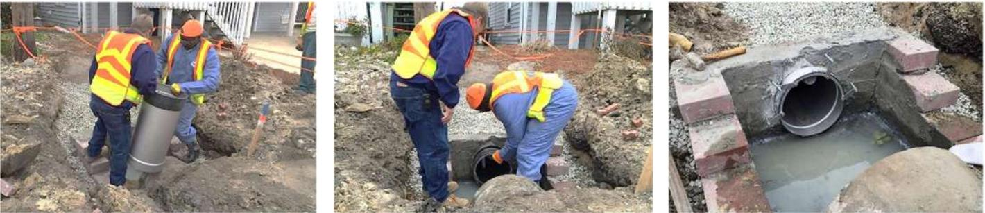
**VOCE DI CAPITOLATO :** Fornitura di valvola antiriflusso in-line serie WS-G in gomma del tipo azionato dal fluido da applicare sulla linea di una condotta avente De ..... mm ; corpo flessibile contenuto all'interno di un guscio in ..... (acciaio inox - PVC - PEAD). Tenuta idraulica 5m H2O. Giunti di accoppiamento valvola-tubo in EPDM con fascette inox
