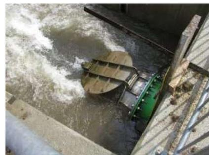
VOCE DI CAPITOLATO : fornitura di valvola a clapet in acciaio ..... ( zincato o rivestito - inox AISI 304 - inox AISI 316 ) a sezione circolare in esecuzione compatta con tenuta su tutta la circonferenza; tenute in EPDM, carico idraulico 3 m H2O; telaio con struttura autoportante per fissaggio ..... ( ad innesto maschio su tubo avente diametro interno Di.....mm – a muro – su flangia forata PN 10 o con flangia a richiesta)
